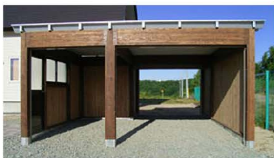
後にもシャッターを設けたガレージタイプ。木製剛構造が可能にした開放性です。
