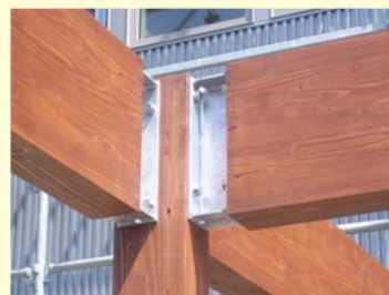
GM工法による柱と梁の接合部
