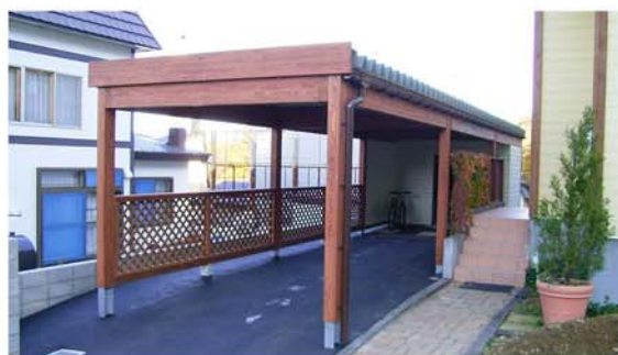
縦2台用のゴーポート。奥に物置を作り、自転車や除雪道具の収納に使っています。
