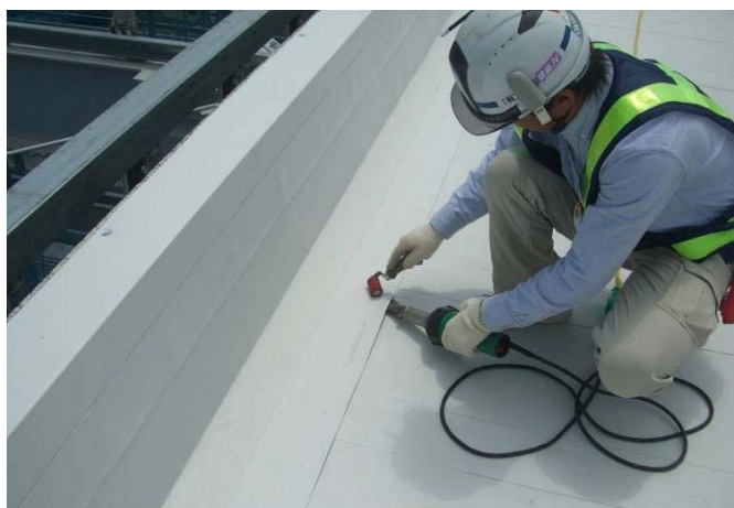
立上り取合部 手動融着機による融着作業
