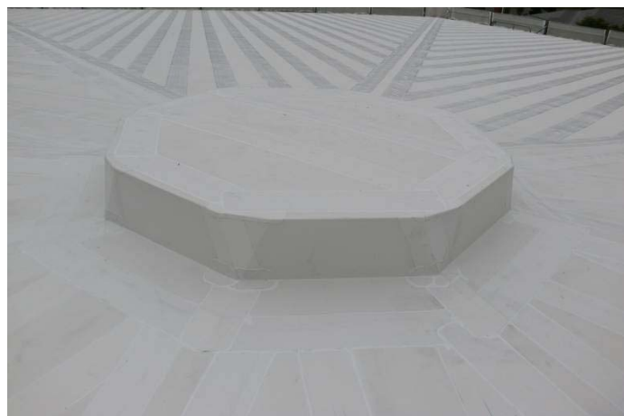
施工完成写真
