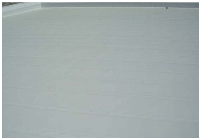
施工完成写真
