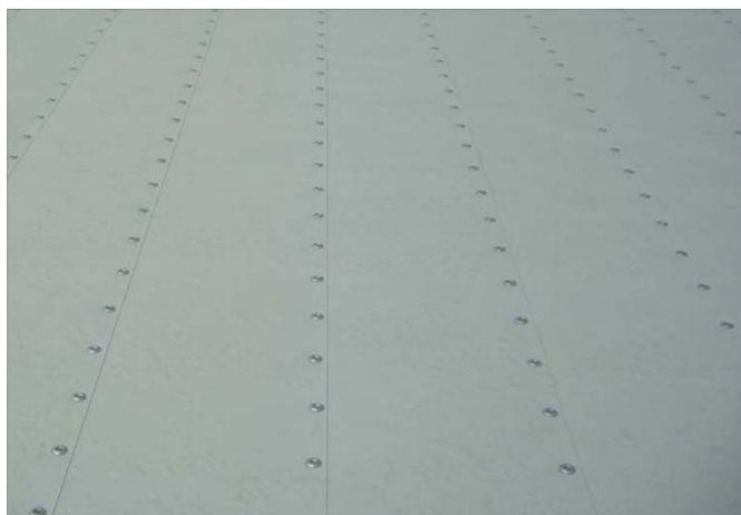
フラットタイプ仮葺き・ビス緊定
