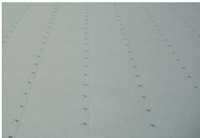
フラットタイプ仮葺き・ビス緊定
