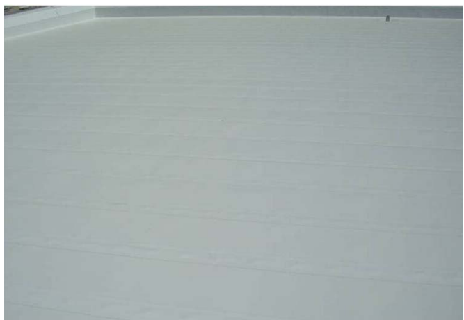
施工完成写真
