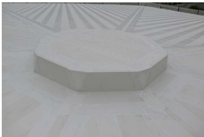
施工完成写真
