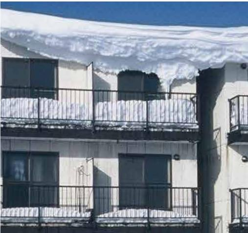
雪庇とは、積雪地域で、屋根の風下側の軒先に雪がせり出し、垂れ下がる現象です。雪を含んだ風が下に巻き込む「渦」となって、軒先に雪が付着して発生し、成長していきます。
