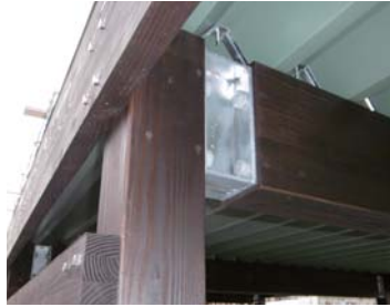
●GM工法による、柱と梁の接合部
